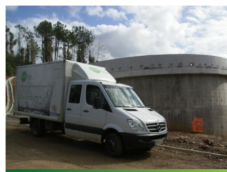
Impermeabilização dos Reservatórios do Complexo da Boavista
