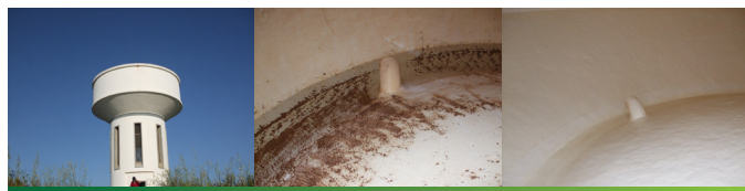
Higieneização de Reservatório de água elevado
