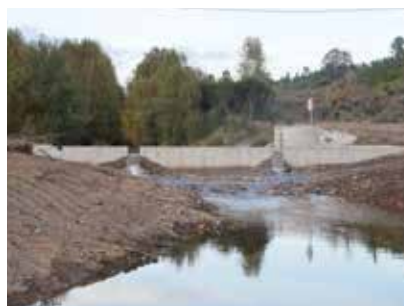
Construção do açude, Ribeira Amilar.
