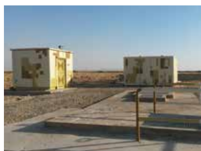
Estação de tratamento de água residual compacta, Argélia.
