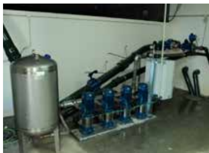
Fornecimento e instalação de grupo de bombagem. M. Vila Nova de Paiva.
