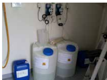
Manutenções de sistemas de tratamento de água. Provincia Portuguesa das irmãs de S. José de Cluny - Braga.
