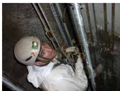
Barragem Pego do Altar - Injeções de resinas e impermeabilizações.
