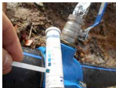
Verificação, através das fitas indicadoras, da concentração da solução em alguns pontos da tubagem.
