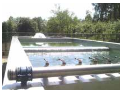
Reabilitação do sistema de filtragem ETA Rio Homem - Vila Verde (2016).
