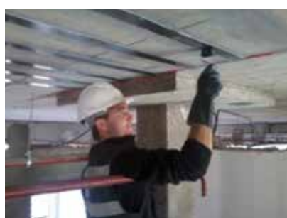
Reforço estrutural de lajes de betão armado.
